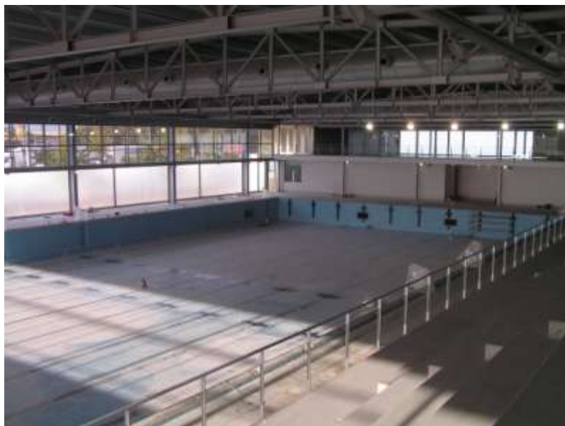
(Imagen de la construcción de la Piscina de dimensiones Olímpicas, octubre 2006)
