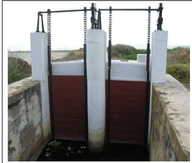
*Compuertas de regulación en salida al mar acequia del Motor*
