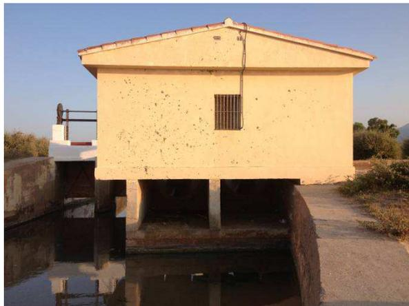
*En la vista desde el mar, además, se observa la construcción del edificio con losa de apoyo en los muros acequia L'Obra*
